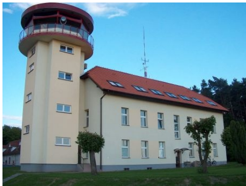
Wieża kontroli lotów - balustrada balkonowa
